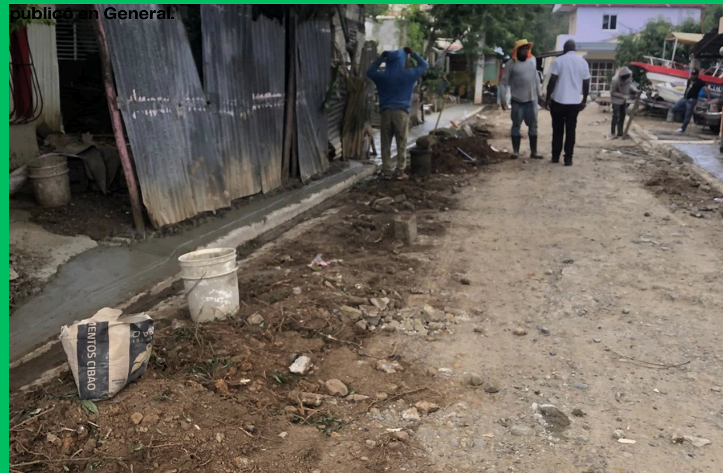
25 de marzo-2026, Construcción de aceras y Contenes en el Sector La Estancia, implementando el presupuesto Participativo 2026. Por parte de la Junta Distrital de Quitasueño.
